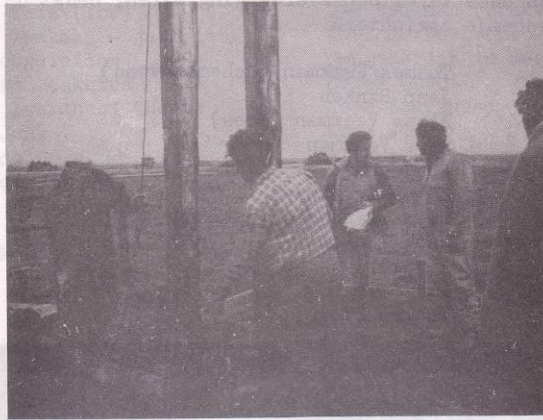
De eerste paal voor "DE SCHEMERPIT" gaat de grond in. Gerrit Kwakman en Cor Sarlemijn bespreken de situatie.
